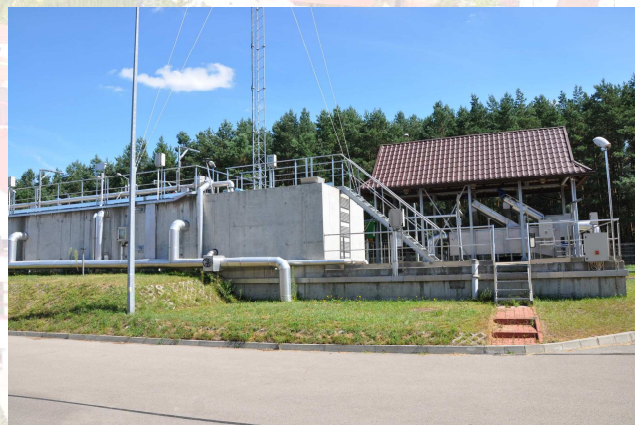
Nowoczesna oczyszczalnia mechaniczno – biologiczna usuwająca związki biogenne wykorzystująca zaawansowany proces osadu czynnego z biologiczną nityfikacją oraz defosfatacją.
